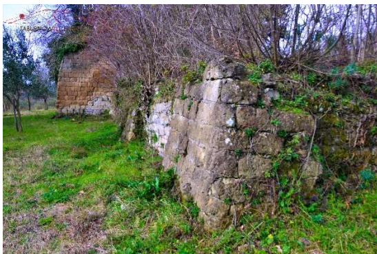
Vista con il muro di contenimento dell'aia
