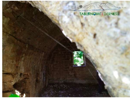
vano principale con abitazione: forno e camino
