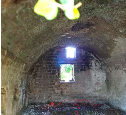
L'ambiente principale con la sua volta a botte Resti di una volta a vella (imposte)
