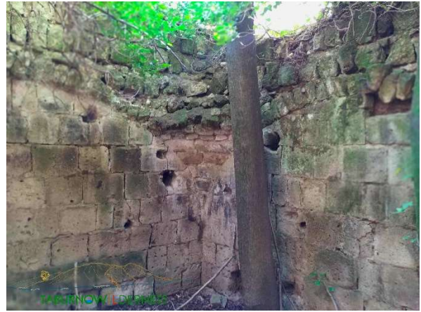
L'ambiente principale con la sua volta a botte Resti di una volta a vella (imposte)
